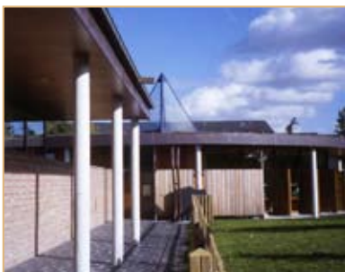
Crèche - Saint Aubin Les Elbeuf - Kérosène architectes
