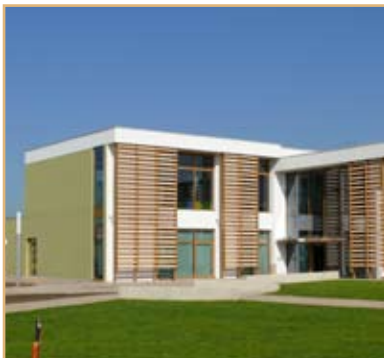
Ecole de musique, de danse, bibliothèque - Saint Etienne du Rouvray - AZ Architecture
